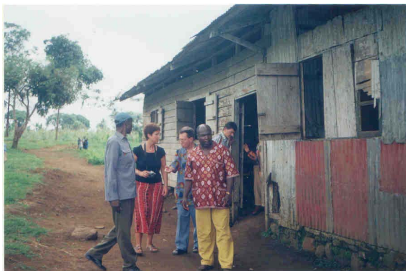
Figuur 2 = inspectie van de onderbouw van Sasse school, een gebouw dat echt aan vervanging toe is
